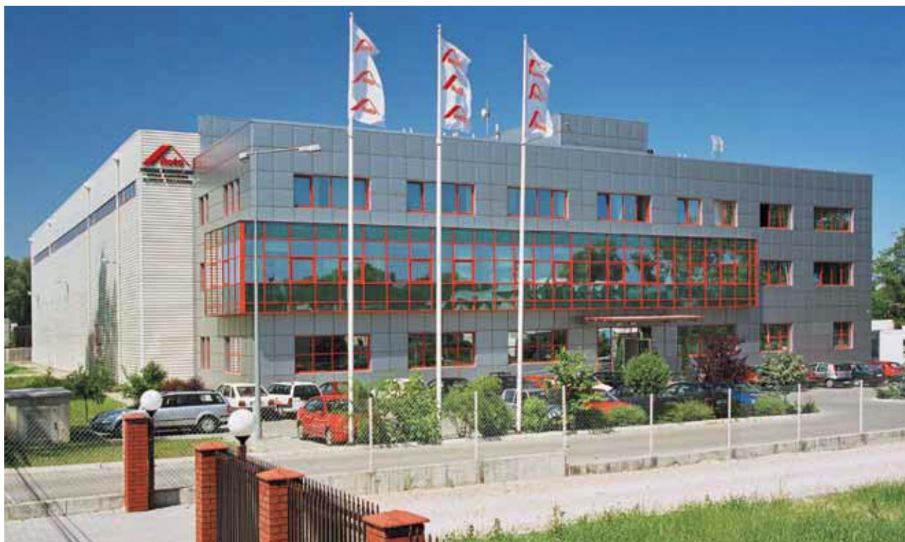
Centrum logistyczne Roto Frank na kraje Europy Północno-Wschodniej w Warszawie
